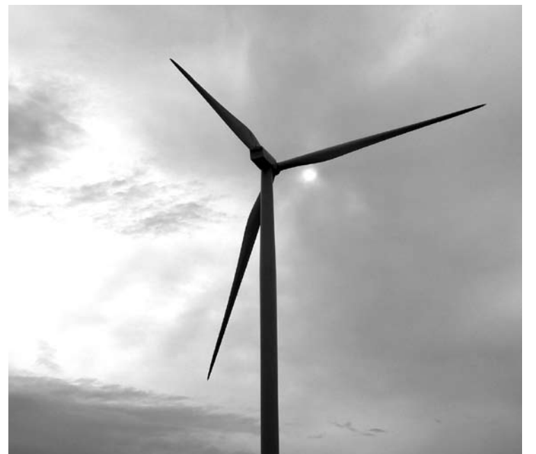
Šalia Staškūniškio jau stovi trys UAB „Renerga“ vėjo elektrinės.
